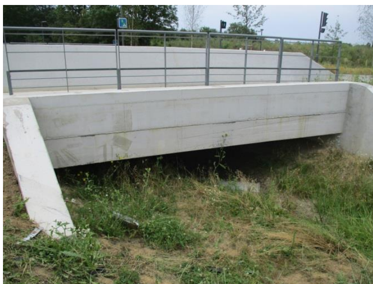
Exemple d'ouvrage existant sur la RD128 à Orsay rétablissant la Rigole de Corbeville (Icare)
