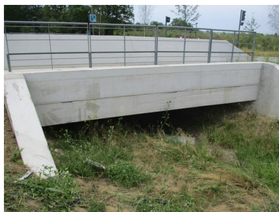
Exemple d'ouvrage existant sur la RD128 à Orsay rétablissant la Rigole de Corbeville (Icare)
